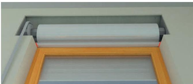
**1. Preparazione del vano cassetto:** la prima operazione è quella di preparare il foro cassetto per l'alloggiamento di CassoMuro. Va innanzitutto eliminato completamente il vecchio cassetto in modo che non interferisca con il nuovo. Dopodichè va pulito il vano interno eliminando detriti e sporcizia. Eventuali altri lavori (cambio del palo o della tapparella, motorizzazioni ...) vanno effettuati prima di iniziare la sequenza di montaggio di CassoMuro.
