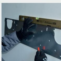
**1** Per prima cosa va fissata la piastra in acciaio sul muro con 4 tasselli e segnati i fori di carotaggio sul muro (perimetro completo) indicando anche il centro del foro utilizzando gli appositi indicatori presenti sulla piastra.
