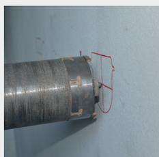
**2** Realizzare il carotaggio (diam 100 mm) con adeguata attrezzatura. Si consiglia l'utilizzo di carotatrici aspirate per evitare la formazione di polvere e dotate di strumento di centraggio per una maggiore precisione del foro. Dopo il foro eliminare con uno scalpello la parte di parete per l'imbocco dei collettori.
