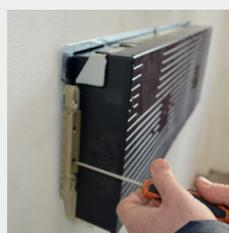
**6** Aprire gli appositi sportellini delle staffe ed alloggiare il corpo macchina assicurandosi che le bocchette di uscita dell'aria imbocchino correttamente i collettori. Chiudere gli sportellini, fare i collegamenti elettrici e completare l'opera montando la cover sulle apposite staffe di alloggiamento.
