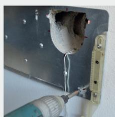
**4** Montare sulla piastra in acciaio le apposite staffe per l'alloggiamento del corpo macchina e avvitare la piastra a muro assicurandosi la corretta posa in bolla
