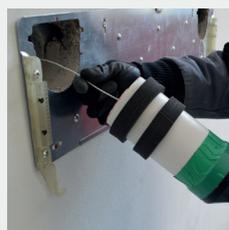
**5** Tagliare a misura i tubi e assicurarli al collettore con l'apposito nastro di tenuta. Al fine di migliorare la tenuta all'aria e al rumore montare sul tubo due strisce continue di nastro termoespandente ed inserire i tubi nel foro alloggiandoli nell'apposito invito sulla piastra in acciaio. Terminare il lavoro schiumando i tubi dall'interno.
